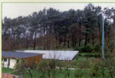
Instalacións solares (térmica e fotovoltaica) e miniaerogenerador
