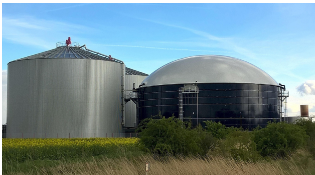
Planta de biogás
