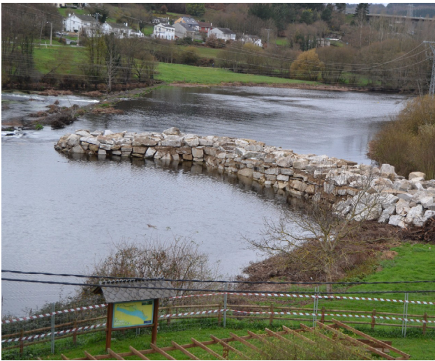
Dique da Fábrica da Luz.
