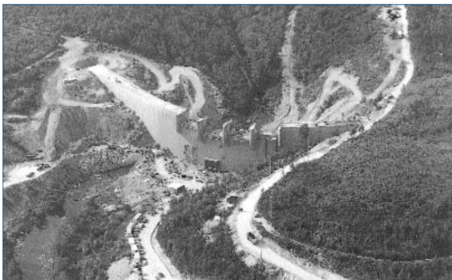
Construción do encoro de Caldas no verán do 2000.
