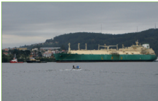
Gaseiro descargando gas licuado na planta regasificadora de Mugardos.
