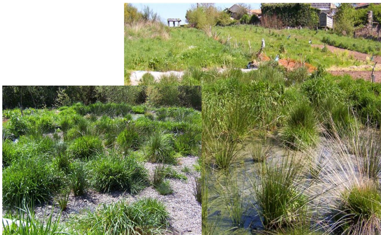
Fotografía das instalacións de depuración de Os Liñares (Beariz). Inclúe un dixestor anaerobio soterrado e un humidal: á esquerda, fluxo subsuperficial; a dereita, fluxo superficial, ambos en proceso de crecemento de xuncos
