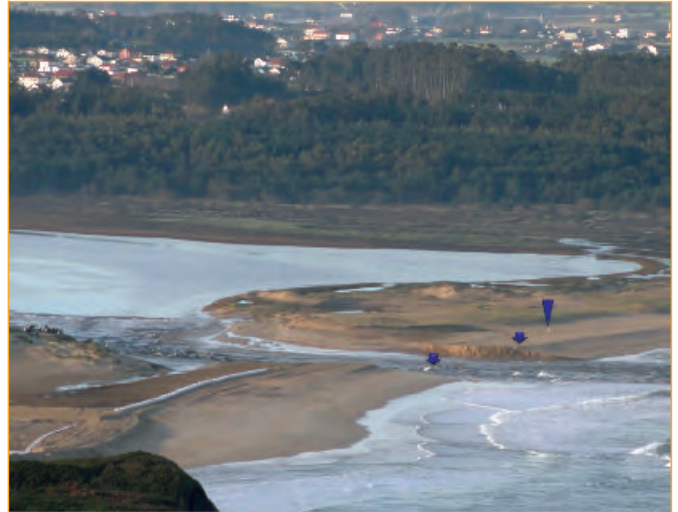
Rotura da barreira de area no mesmo punto onde os bulldózers traballaron incesantemente e baleirado da lagoa (30/01/2012).
