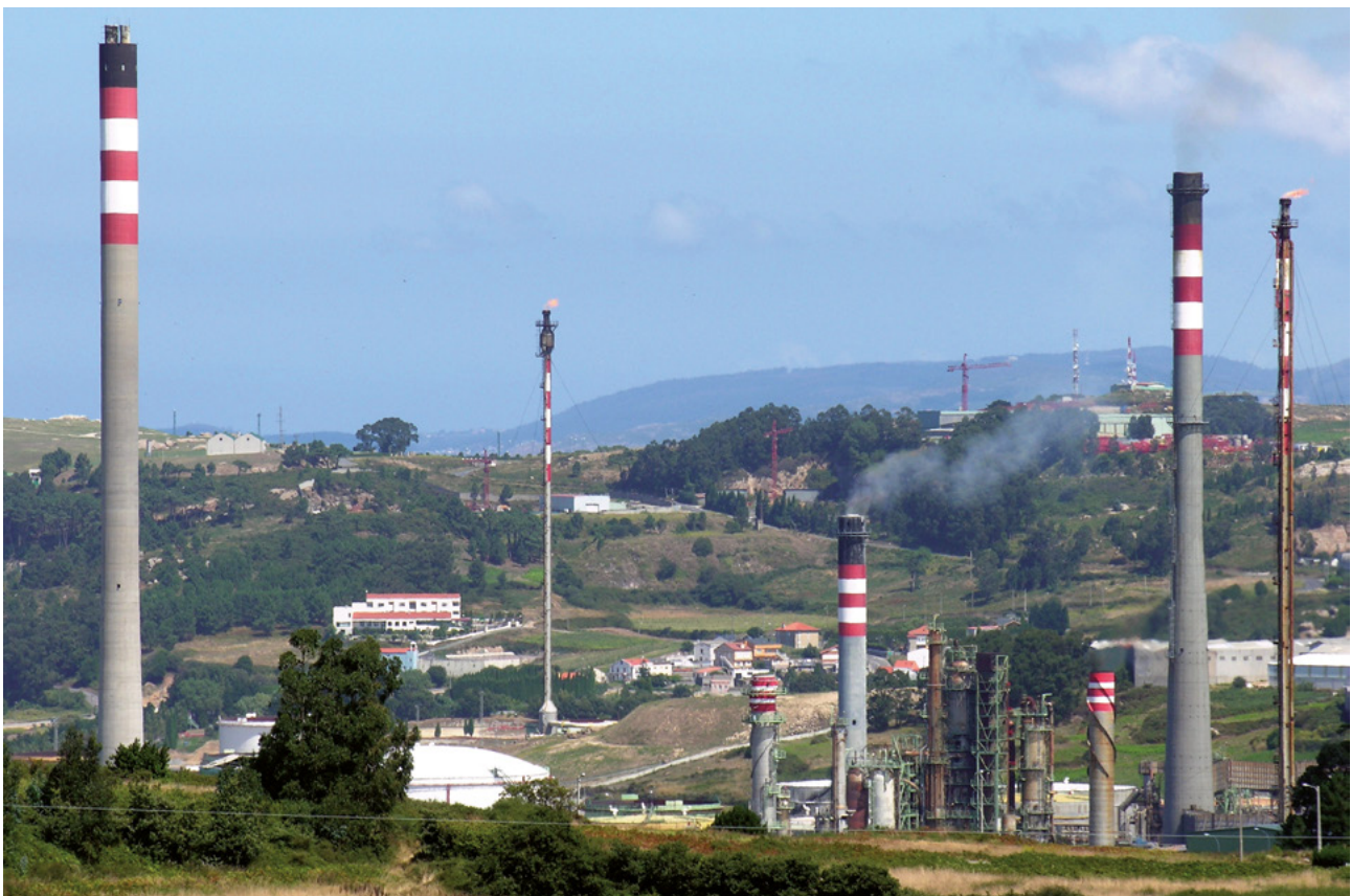
A refinaria de petróleo de Repsol, no Polígono Industrial da Grela-Bens (A Coruña), vista desde Arteixo · Wikipedia
