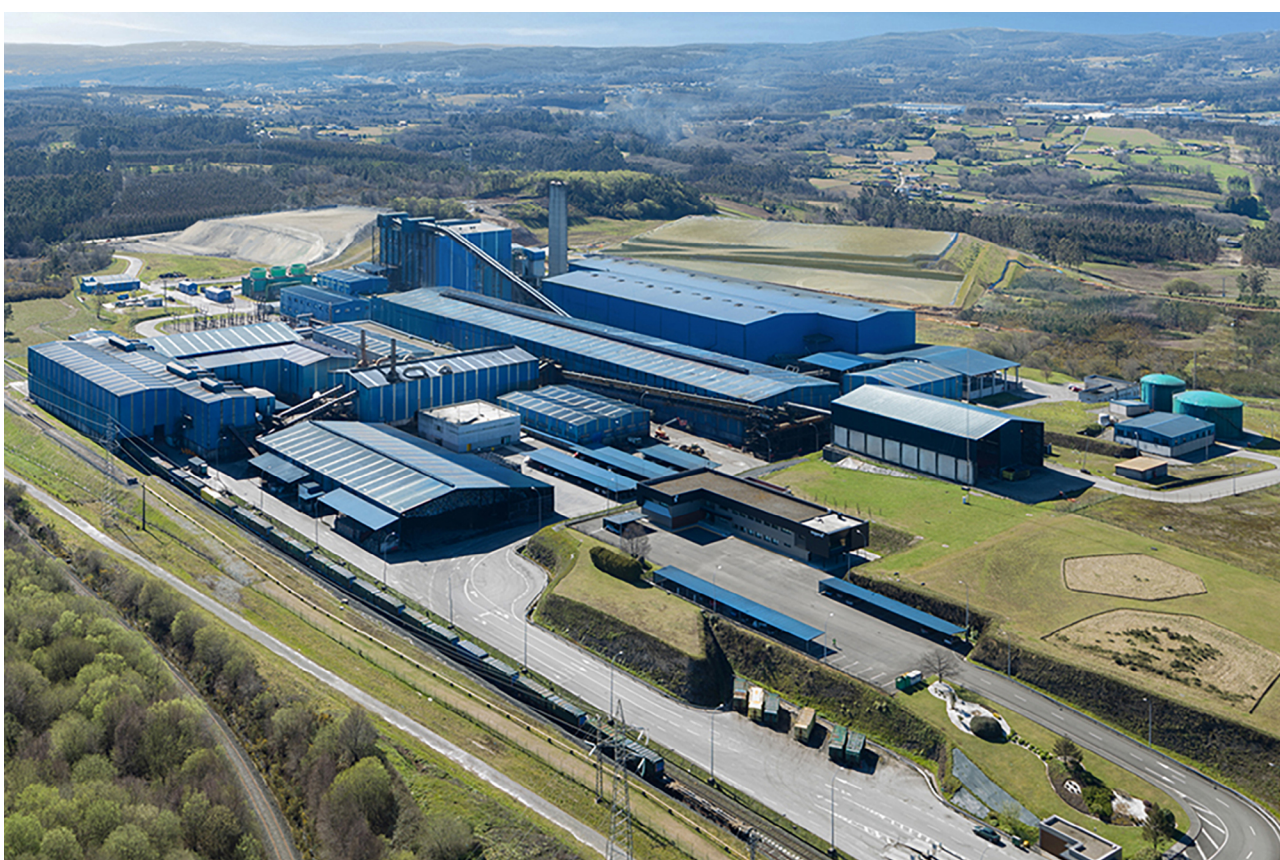
Planta de SOGAMA en Cerceda · SOGAMA
