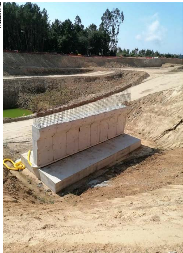
Obras para a construción da Vía Ártabra.
