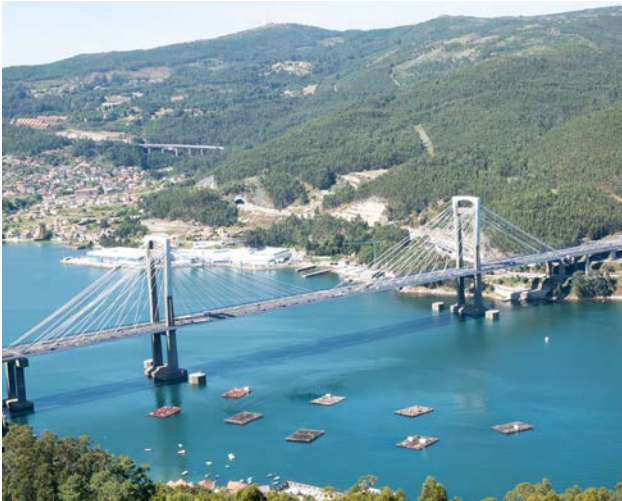
Bateas situadas ao lado da ponte de Rande.
