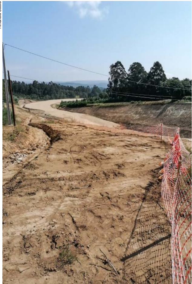
Construción do tramo preto da N-VI, en Iñás.
