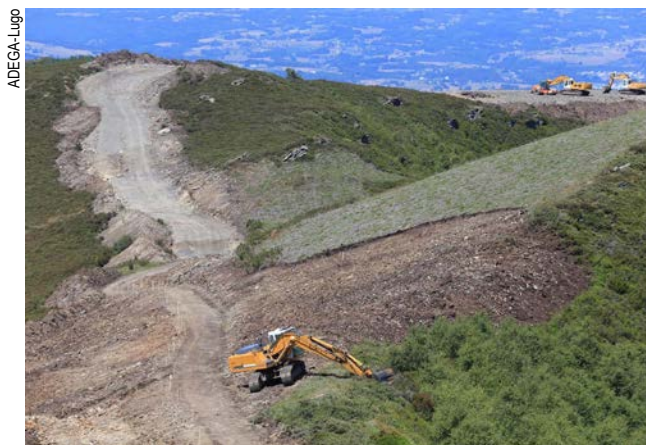
Obras de construción do parque eólico do Iribio, anulado pola xustiza en 2020.
