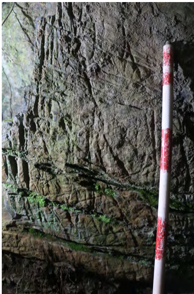
Figura 27. Fisuras naturais da parede rochosa.
