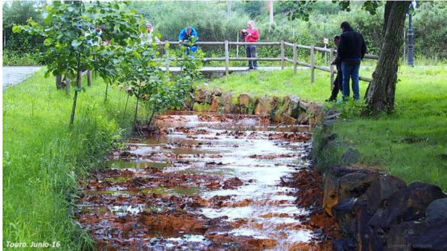
Figura 12. Estado actual de la salida del Portapego.
