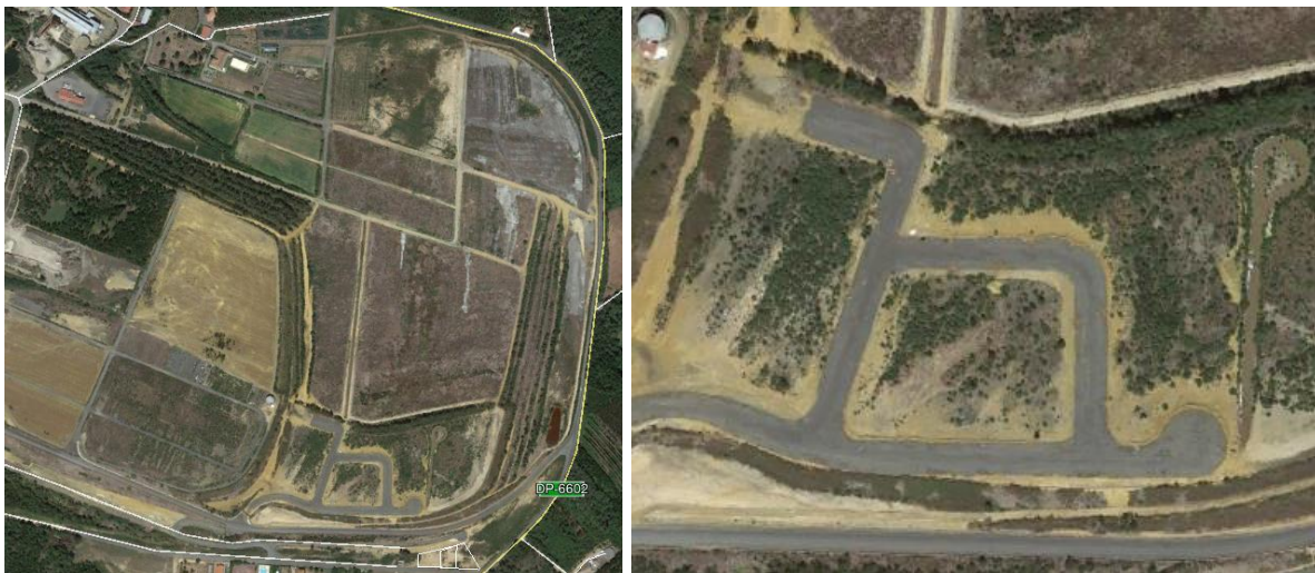
Figura 33. Estado actual del antiguo depósito de estériles de Touro.
