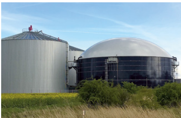
Planta de biogás · Adobe Stock
