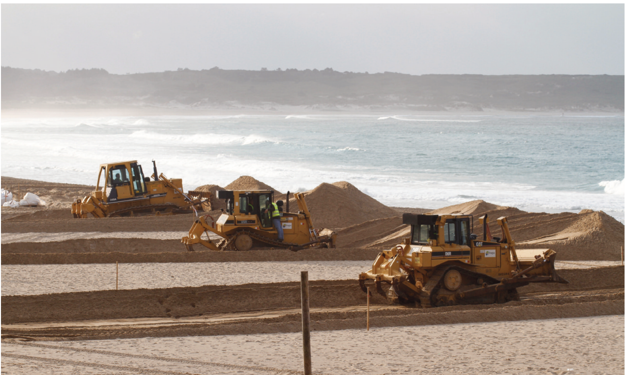
Maquinaria pesada alterando a configuración da barreira litoral e o perfil da praia.
