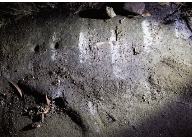
Petróglifo de Agro do Campo 1 afectado polo paso da maquinaria pesada empregada na extinción do lume de Villestro (Santiago de Compostela) no ano 2016.
