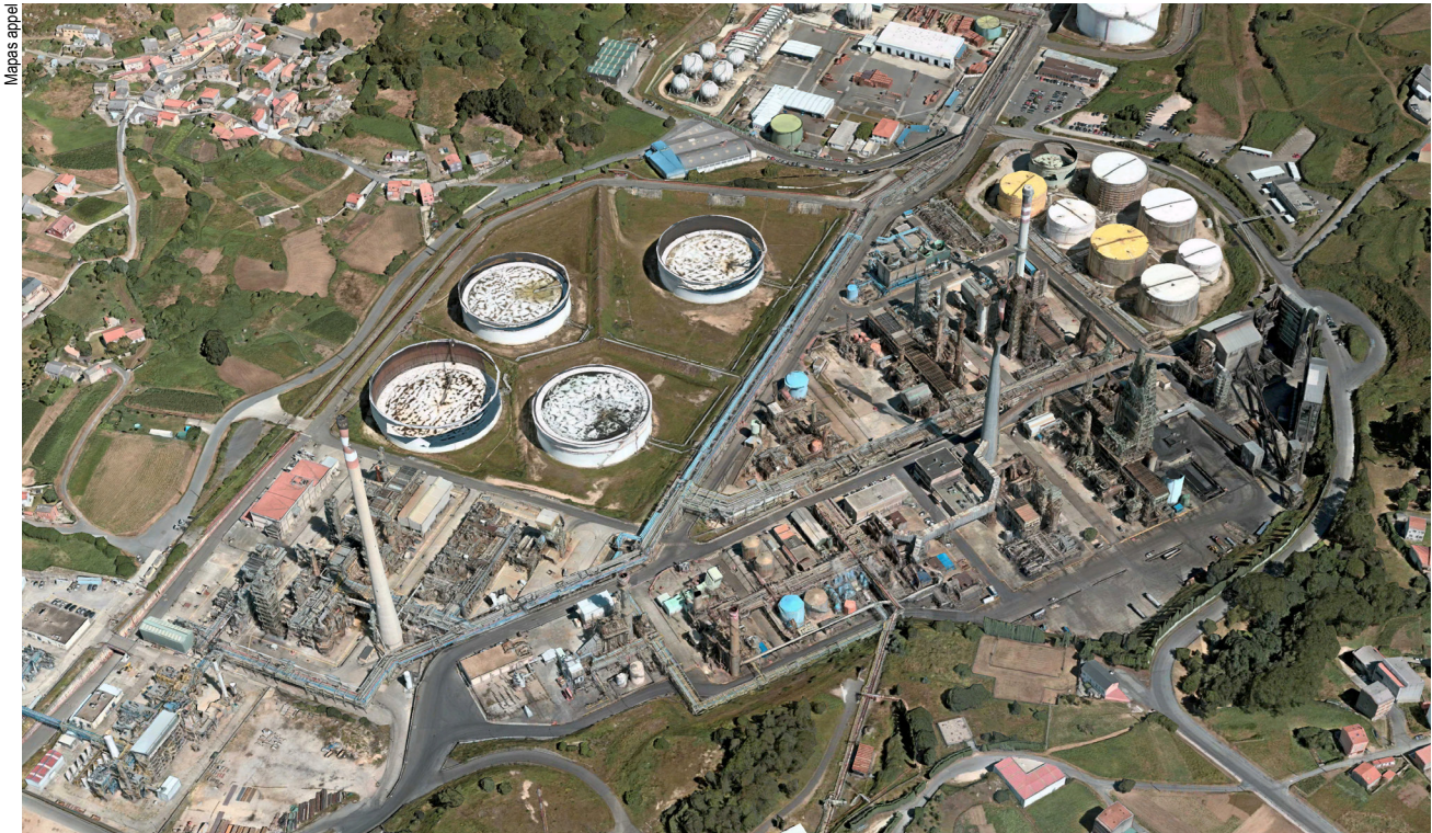
Air Liquid Ibérica na Coruña.
