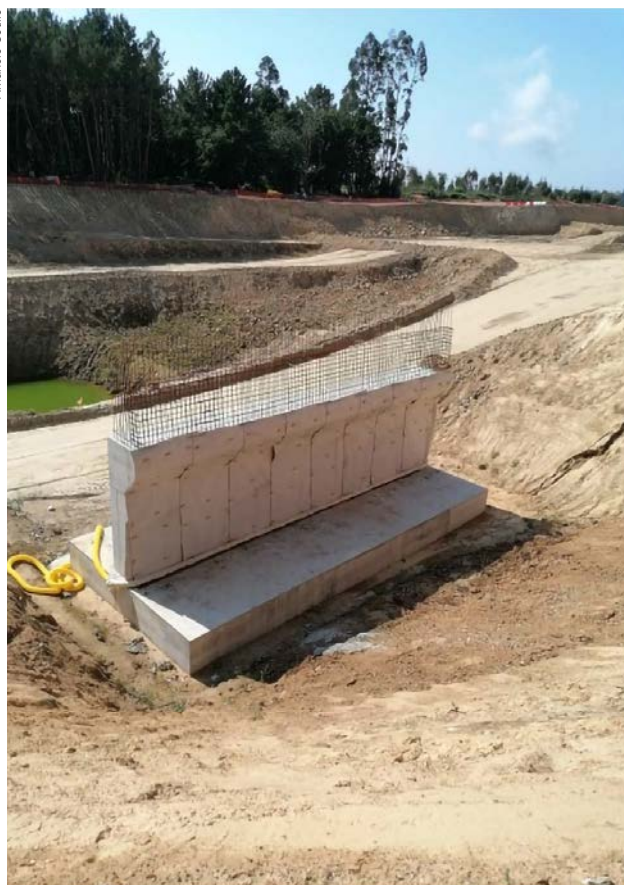
Obras para a construción da Vía Ártabra.
