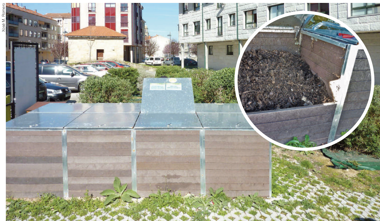
Zona de compostaxe comunitaria da Praza do Pombal. En detalle, módulo de compostaxe previo ao cribado.
