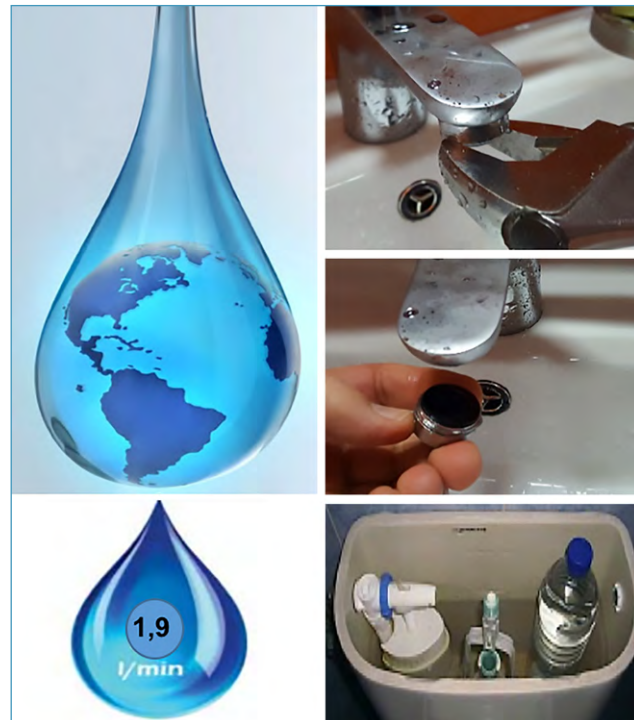
Medir o consumo de auga nos equipamentos, cambiar os aireadores por outros de baixo consumo, reducir os volumes de descarga das cisternas ou substituír os mecanismos de descarga única por outros de dobre descarga, son actuacións sinxelas e baratas que permiten aforrar auga.
