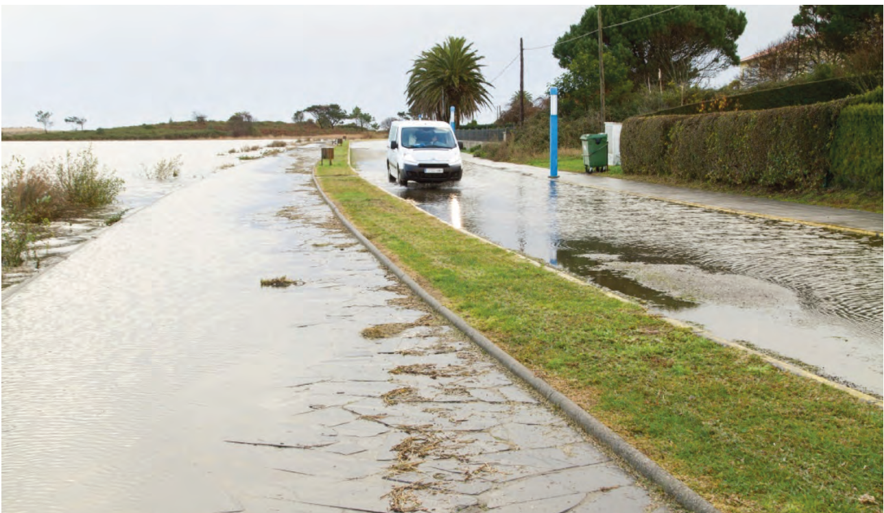
Vista do paseo marítimo que rodea parcialmente o vaso lagoar. A construción deste paseo realizouse sen ter en conta a dinámica hidrolóxica do humidal, situándose a superficie de rodaxe por baixo do nivel ordinario da inundación invernais.
