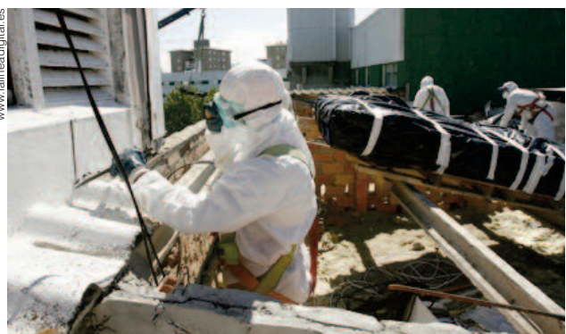
Operarios dunha empresa especializada retirando amianto dun tellado.
