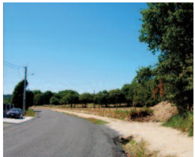
Desvío artificial do Camiño Primitivo, seguindo a estrada para “facilitar” o tránsito dos peregrinos nun treito de calzada histórica ocupada.
