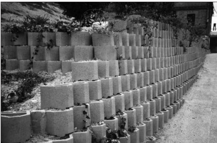
Figura 9.10. Muro de bloques ou xardineiras en Cristo del Otero (Palencia) (foto: J. Navarro)
