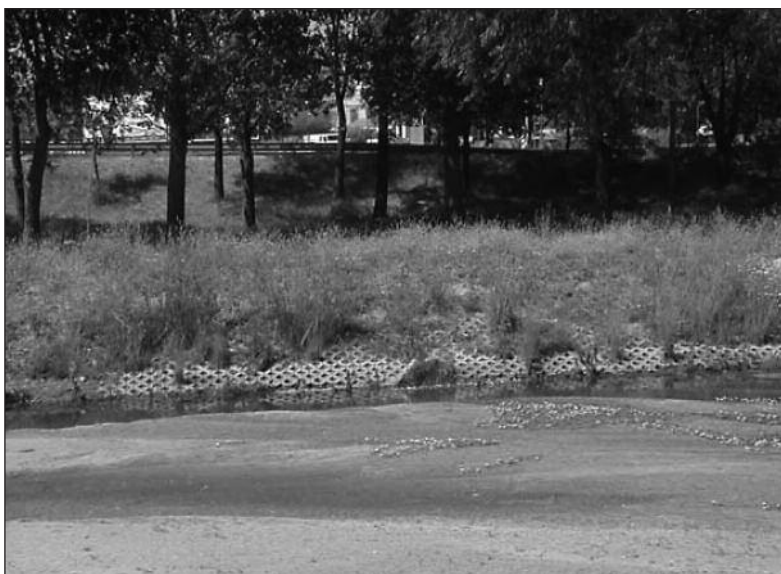
Figura 9.6. Bloques ocos de formigón prote- xendo a ribeira do Río Chico (Ávila) (Foto: A. Sáiz)
