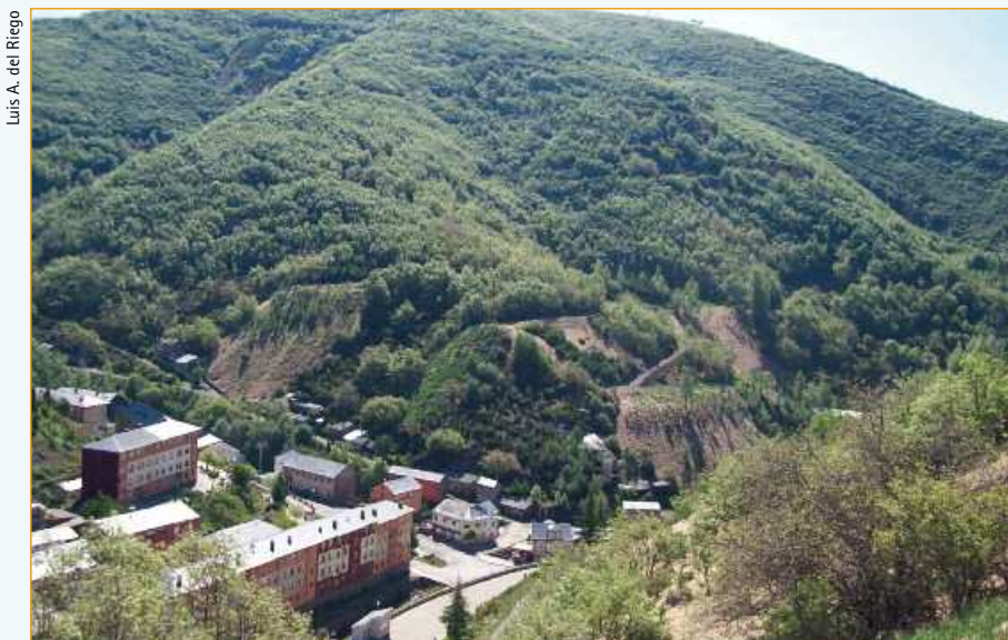
Entulleira de Tremor en restauración.
