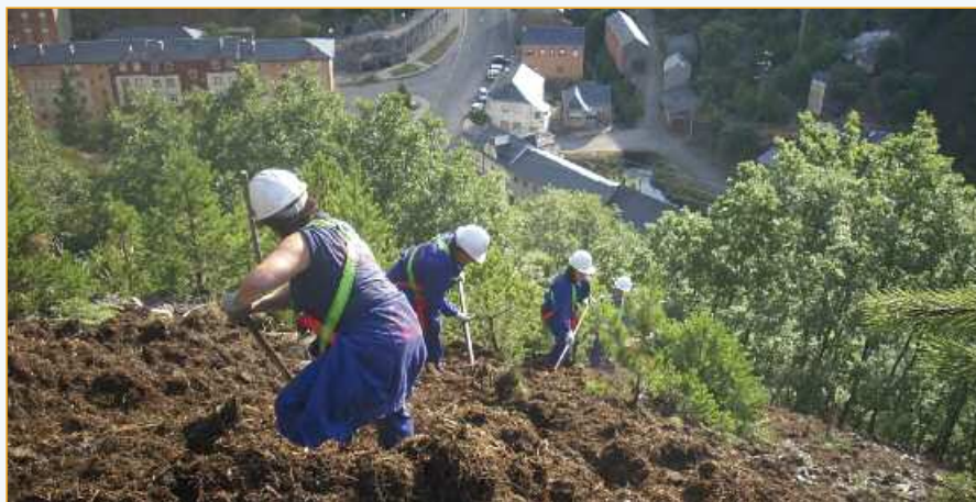
Operarios traballando na restauración da entulleira en Tremor.
