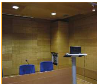
Auditorio revestido con paneis perforados de madeira a modo de resoadores.
