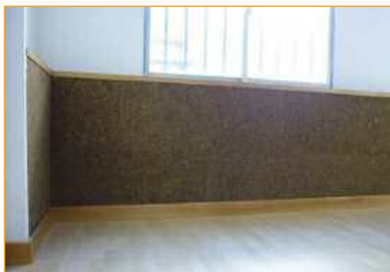
Trasdosado con pranchas de biomasa.
