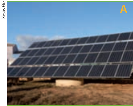
Seguidores solares: a) Seguidor con regulación azimutal e 35° de inclinación, b) Seguidor solar instalado en Vilalba de 345 m 2 deseñado por unha empresa Lucense, c) Seguidor solar de 1 eixe no parque experimental de Sotavento (Xermade, Lugo).
