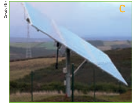
Seguidores solares: a) Seguidor con regulación azimutal e 35° de inclinación, b) Seguidor solar instalado en Vilalba de 345 m 2 deseñado por unha empresa Lucense, c) Seguidor solar de 1 eixe no parque experimental de Sotavento (Xermade, Lugo).
