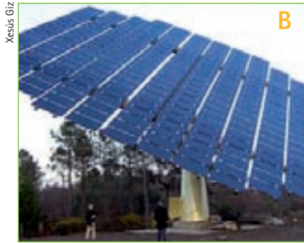
Seguidores solares: a) Seguidor con regulación azimutal e 35° de inclinación, b) Seguidor solar instalado en Vilalba de 345 m 2 deseñado por unha empresa Lucense, c) Seguidor solar de 1 eixe no parque experimental de Sotavento (Xermade, Lugo).
