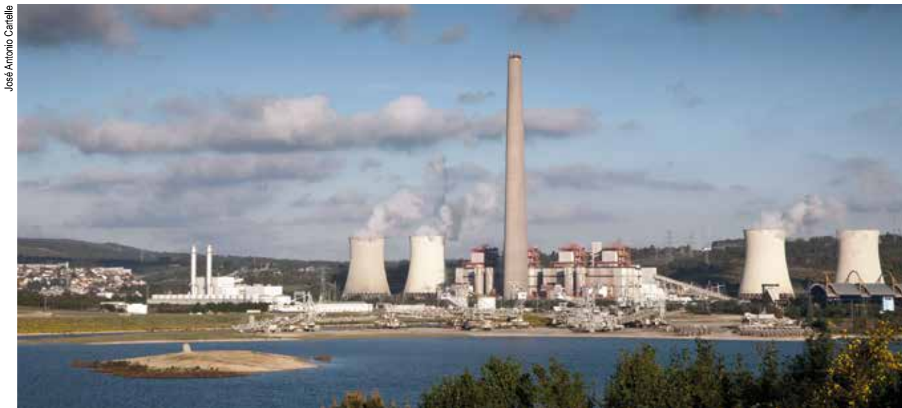
Central Térmica de As Pontes.
