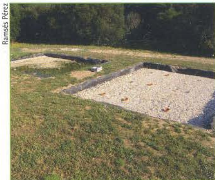
Humidais demostrativos en A Silvouta (Santiago de Compostela). Cronoloxicamente: escavación das balsas (esquerda), balsas rematadas xa en funcionamento (medio), balsas con xuncos en proceso de crecemento (dereita)
