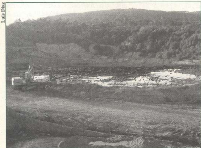
As balsas con residuos de fuel teñen que estar completamente impermeabilizadas e situarse a mais de 2000 m. das vivendas mais próximas
