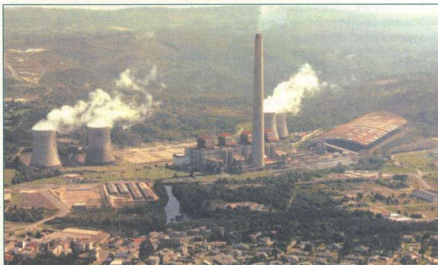
A central térmica de carbón das Pontes é a máis contaminante do Estado español. Vaise ampliar con novos grupos de ciclo combinado a gas natural.
