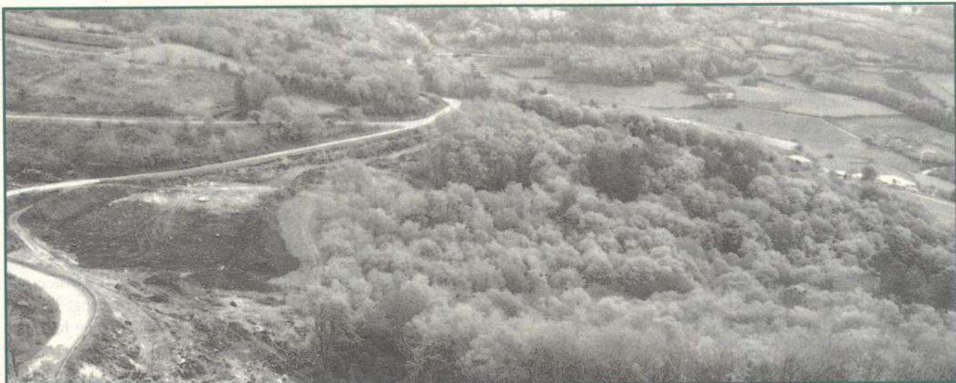
Obras da estrada PO-200 o seu paso pola Serra do Candán
