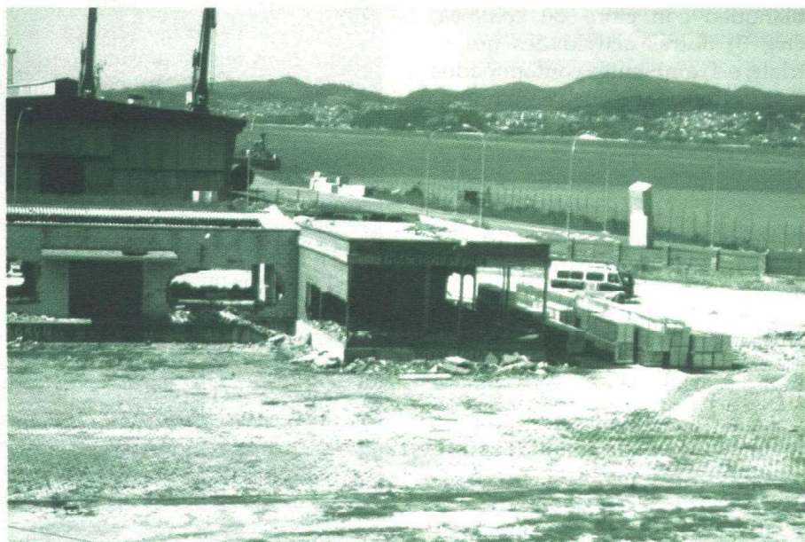
Obras da empacadora de Guixar, vistas desde a aceira dos edificios colindantes
