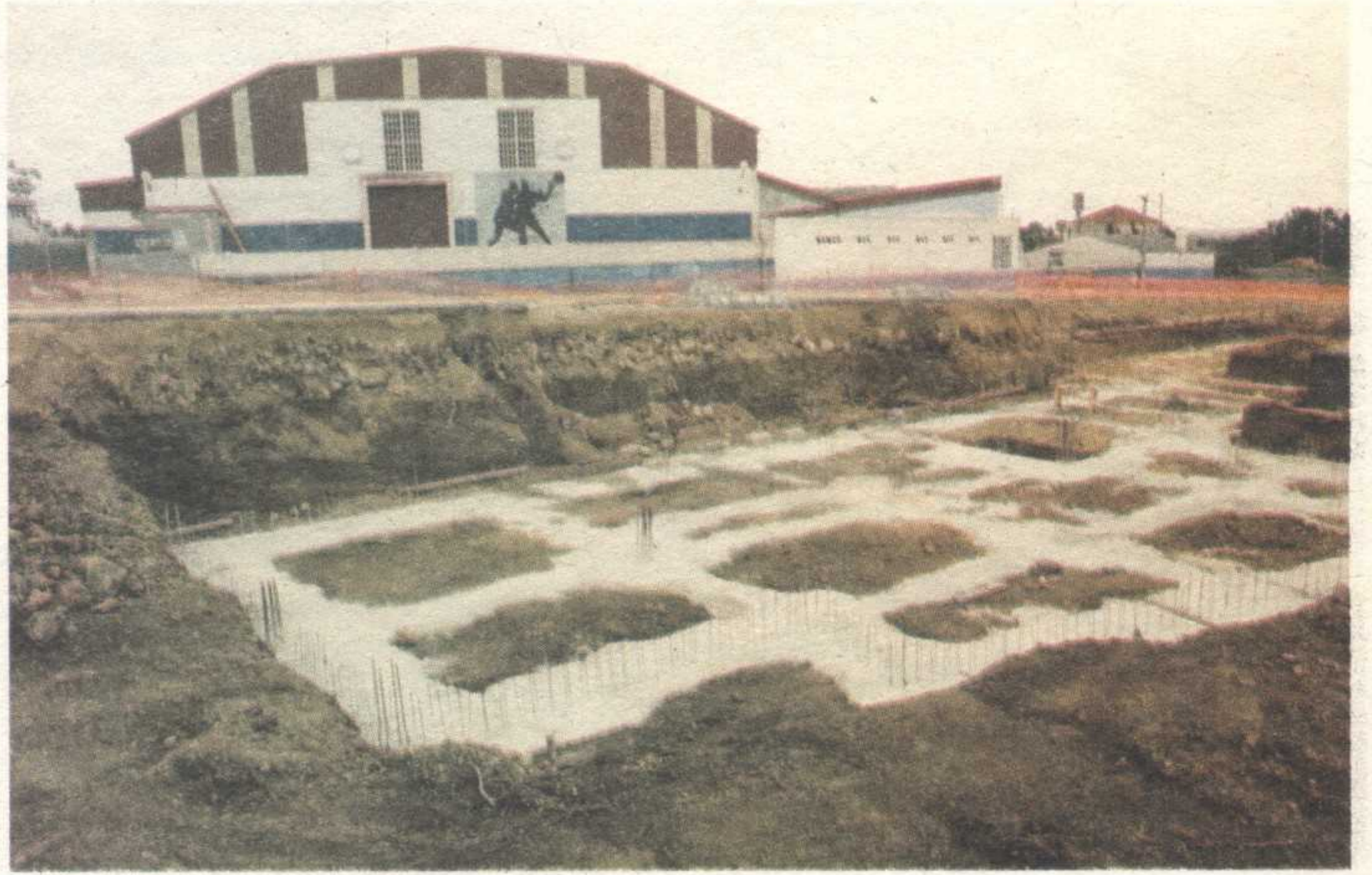
Auditorio de Cerceda en construción.
