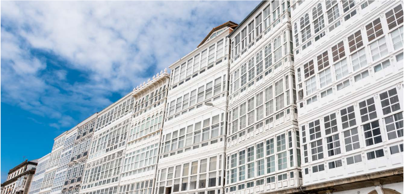
Fronte de galerías (A Coruña) · Toni
