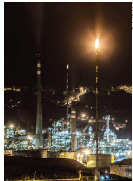
Refinaria de Repsol na Coruña
