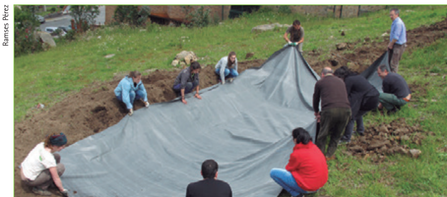
Colocación da lámina impermeábel na charca do campus da UDC.
