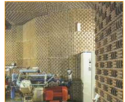
Sala de máquinas revestida de absorbentes acústicos de espuma branca de poliuretano.
