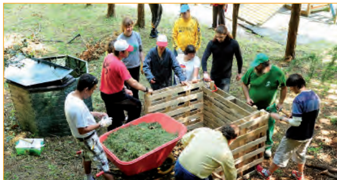
Instalación da área de compostaxe en Fene, xunto cos voluntarios/as e os veciños/as.
