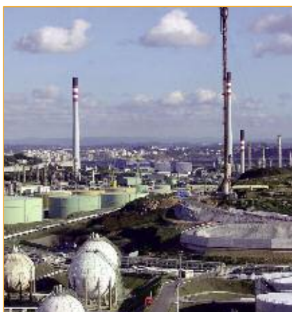
Refinería de Repsol (A Coruña).
