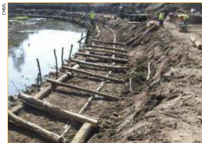
Exemplo de execución das primeiras alturas do muro, mediante a creación das celas con troncos de madeira.
