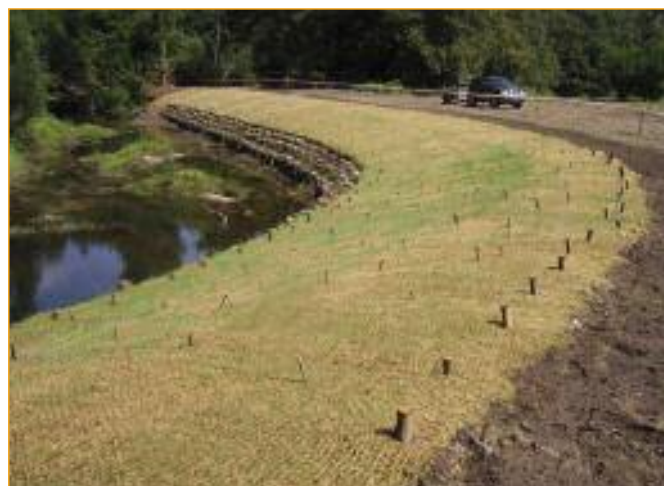
Detalle final do talude rematado con manta de coco.
