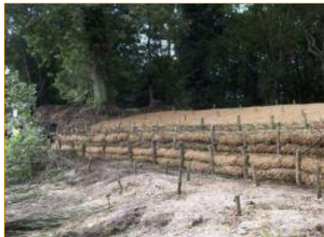
Detalle da execución de contención do talude con biorrolo.
