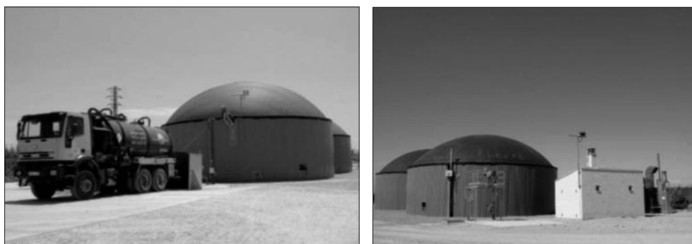
Figura 8. Fotos da descarga de substrato e dos dixestores de Ecobiogas.
