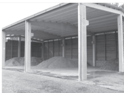
Nave para almacén de biomasa
