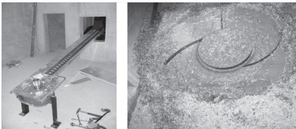
Figura 4. Sistema de alimentación da caldeira (esquerda:montaxe; dereita: en funcionamento).
