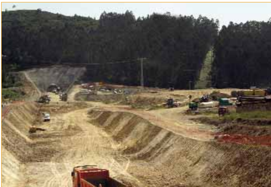
Obras para o tren de alta velocidade no treiro Osebe-Padrón.
