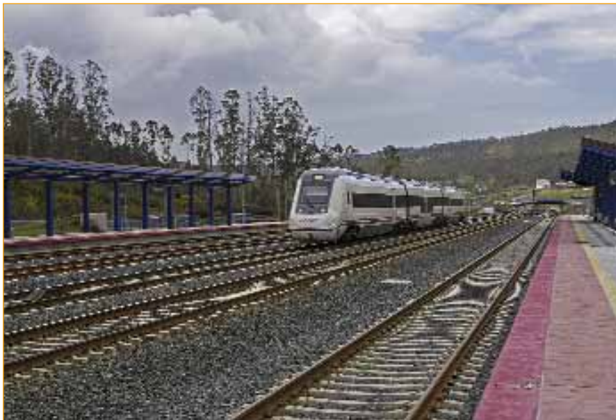
Estación de Cerceda/Meirama, por estas vías pasará o AVE Coruña-Vigo.
