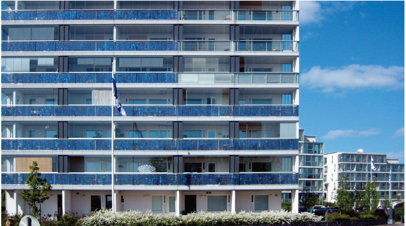
Edificio en Helsinki (Finlandia) con placas solares nos balcóns, a través das cales se xera enerxía fotovoltaica.
