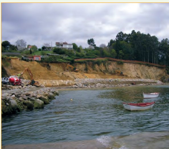
Figura 1: Traballos de estabilización de cantís na Praia de Redes, Ares.
