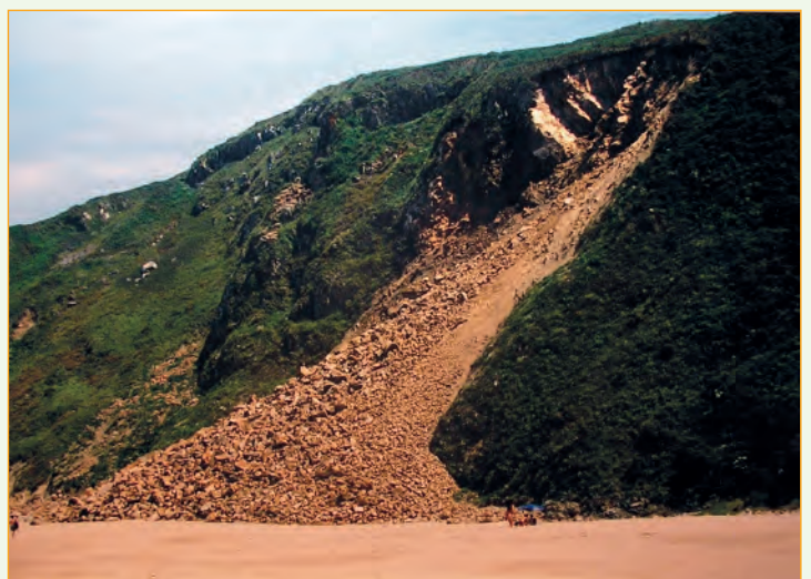
Figura 2: Desprendemento na Praia de Ponzos, Ferrol.
