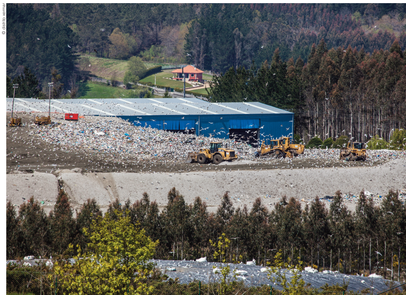
Vertedoiro de SOGAMA na Areosa (Cerdeira).
