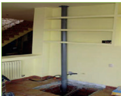
Gráfico 2. Construción dunha arqueta de succión co seu rematado final, onde destaca a cheminea de tubo de PVC que arranca da arqueta por baixo do solo da casa e sobe até o tellado, disimulada por tras dun estante de obra. Caso real de domicilio en Pontevedra medido antes e despois polo Laboratorio de Radon de Galicia.
