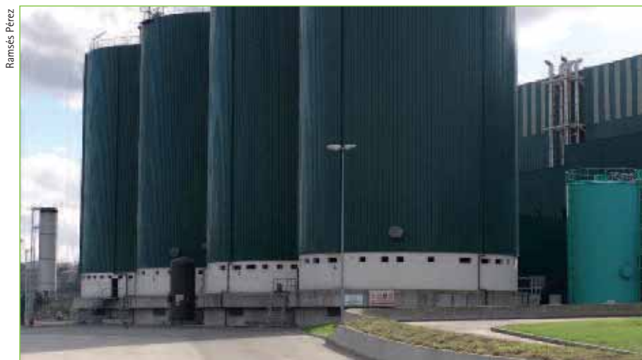
Dixestores da planta de Nostián.
