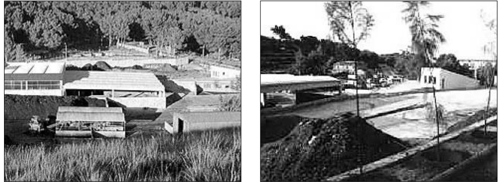
Figura 2.8. Planta de compostaxe de Castelldefels
