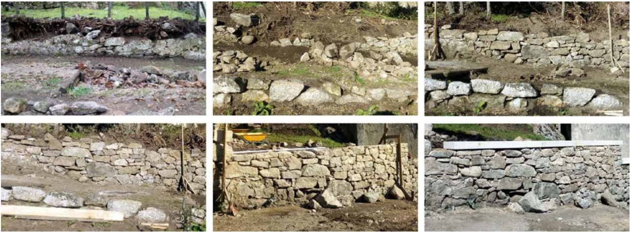
Fases na reconstrución dun valado de contención · Xosé María Lomba
