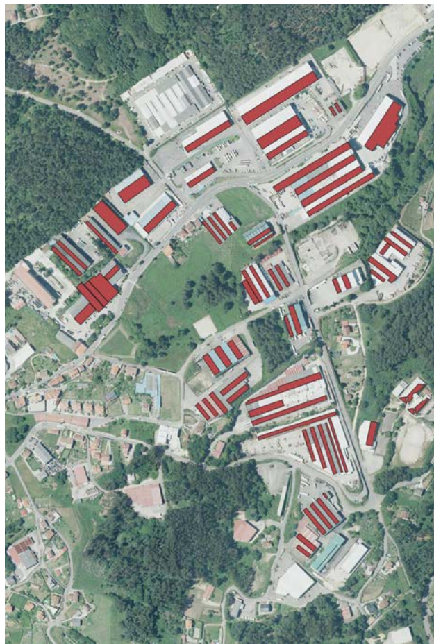
Cubertas susceptibles de poñer paneis solares • Comunidade de Montes de Tameiga.
